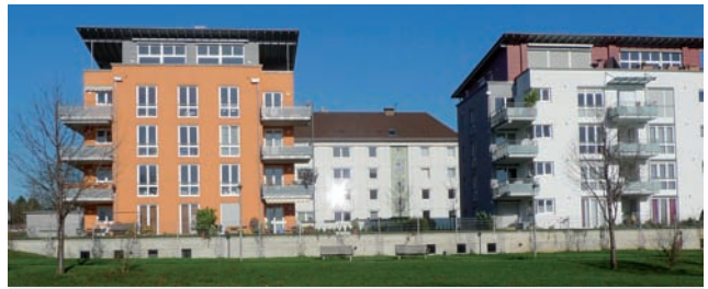
Teil eines Verbundkraftwerks für das Wohngebiet Sonnenberg in Ludwigsburg ist eine zentrale Erdwärmeanlage.
