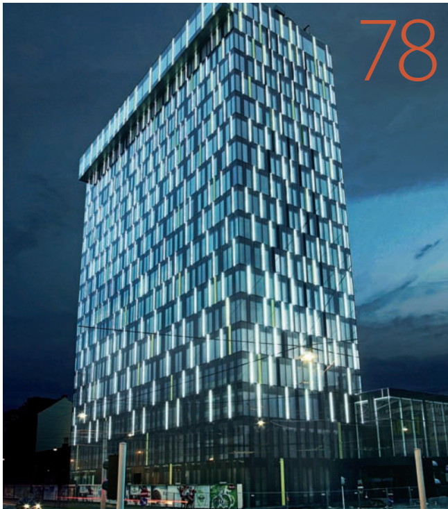
Erdgekoppelte Großwärmepumpen heizen und kühlen den Power-Tower in Linz.
